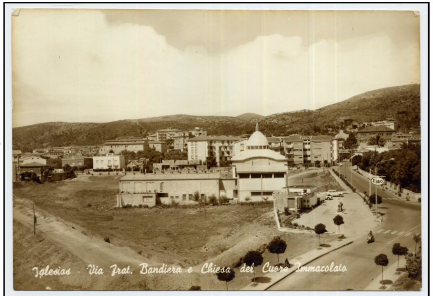
Veduta della chiesa parrocchiale dal lato est. Si noteranno le differenze: è già presente il distributore, ma della via Indipendenza si nota solamente un tracciato sullo sterrato.
