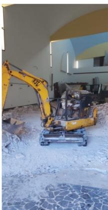
metri sotto il livello stradale, soffre dell'umido che risale per capillarità dalla terra. Il pavimento precedente era stato realizzato con la tecnica dei pezzi di marmo accostati e cementati da malta tra pezzo e pezzo. Ebbene, alla lunga, l'umidità aveva fatto saltare in molti
